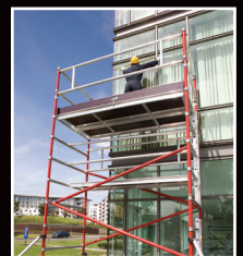
Turm mit Deckanstrich
